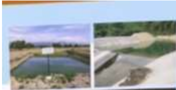
อ่างเก็บน้ำเขื่อนลำนานและเขื่อนน้ำ เพื่อการอนุรักษ์ดินและน้ำในโครงการชลประทาน
